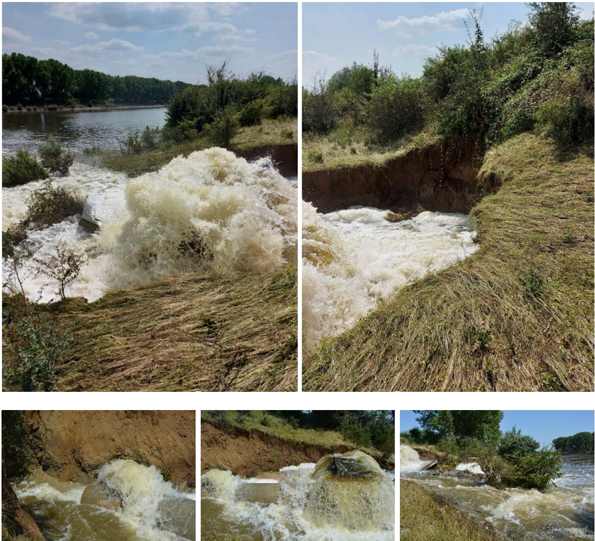
Figuur C.8.1: Zeven Ellen Waterlaat nabij Horn, boven: situatie op 21 juli (foto's Erik Bijlsma, Rijkswaterstaat), onder: situatie op 23 juli bij een peil in het retentiegebied circa 1,95 onder de piekwaterstand
