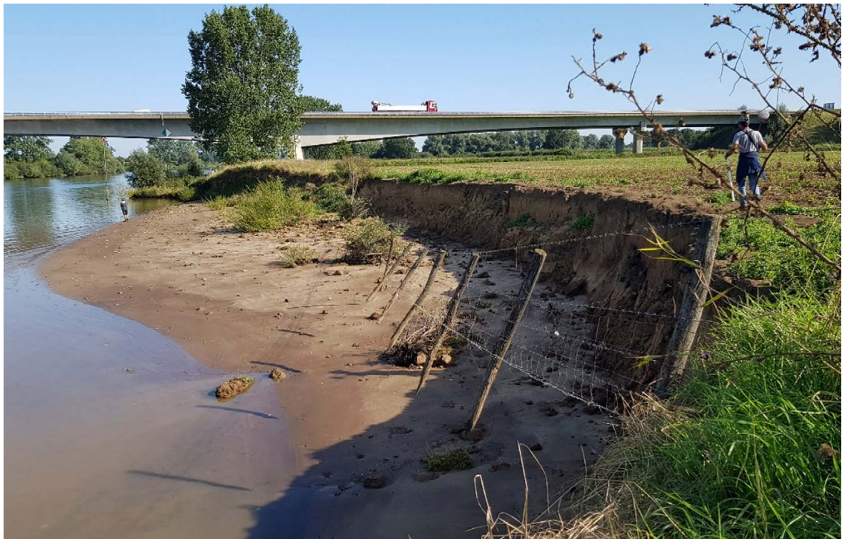
Figuur B.3.4.6: Boxmeer, Zuidereiland (op deze locatie was de erosie voor het hoogwater al aanzienlijk, maar gedurende het hoogwater heeft de erosie verder doorgezet).
