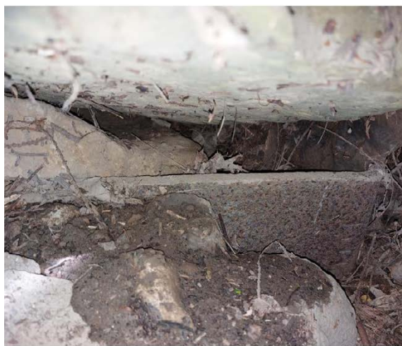
Figuur 4.7: Keersluis Roer, met achtereenvolgens afgezet zand en grind bij de eerste zandzakken (foto Guido van Rinsum, Witteveen+Bos), opkisting op 17 juli om 4:30 uur (foto Guido van Rinsum, Witteveen+Bos), opkisting op 17 juli rond 20:00 uur (foto Guido van Rinsum, Witteveen+Bos), de slechte aansluiting van de sluisconstructie op de bovenkant van de damwand aan de hoogwaterzijde.
