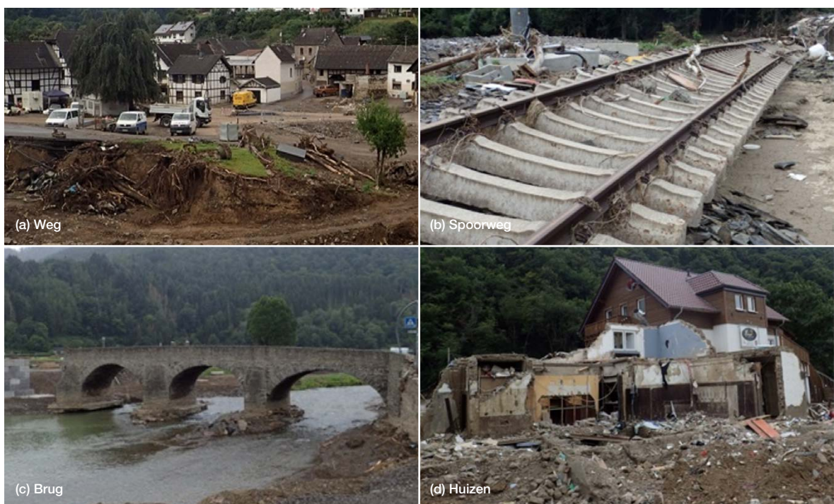
Figuur 8.7: Schade aan diverse structuren in de Ahr-vallei.
