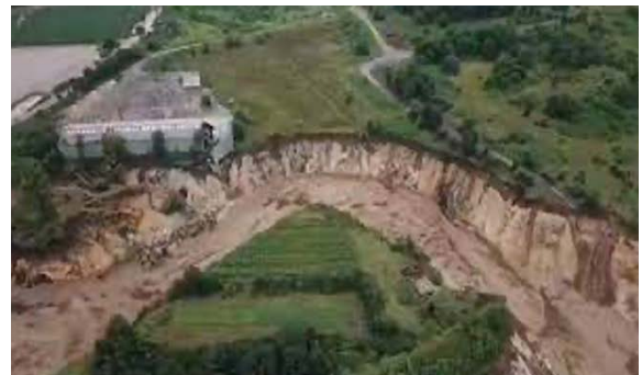
Figuur 8.5: Lege dam bij Steinbach met zichtbare overstromingsschade. (General Anzeiger, 2021. Foto: dpa/David Young)
